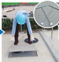
② ステンレス板を留めてあるボルトを外し、工具2本を使ってステンレス板を撤去
